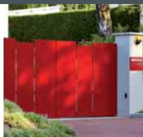
Boîte encastrée dans le pilastre
